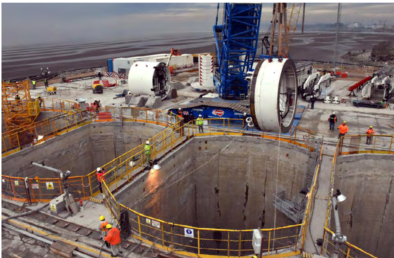
Obras en Marcha. Sistema de Riachuelo. ACUMAR, 2019
