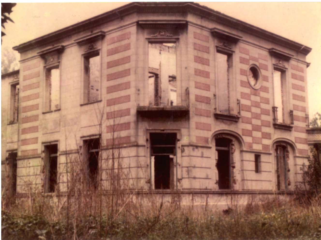
Mansión Seré Casona en pie. Estructura arquitectónica. Archivo Fotográfico de la Casa de la Memoria y La Vida. Dirección de DD.HH. de Morón, Buenos Aires, 1984. Sin Autor/a
