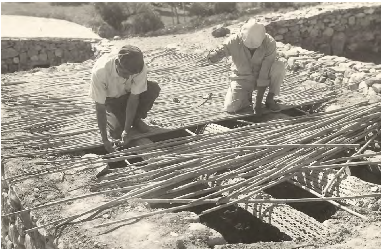
Reconstrucción del Pucará. Techado de un recinto del barrio de la entrada con cañas sobre bigas de cardón. Pucará de Tilcara, año estimado 1948
