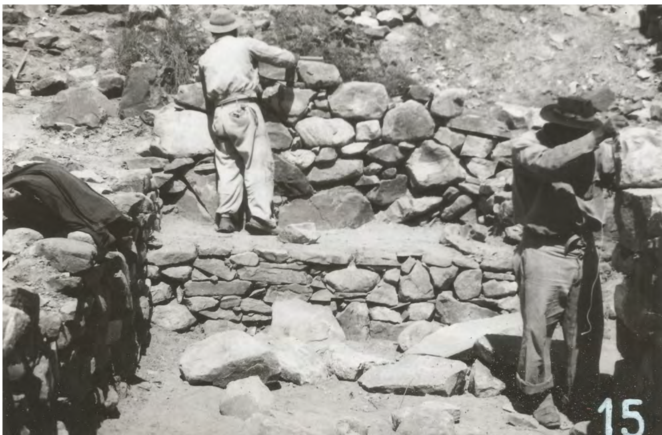
Reconstrucción del Pucará. Pircado de un recinto siguiendo los cimientos con técnica milenaria de “pirca seca” (piedra sobre piedra, sin ningún material de junta). Pucará de Tilcara, año estimado 1948
