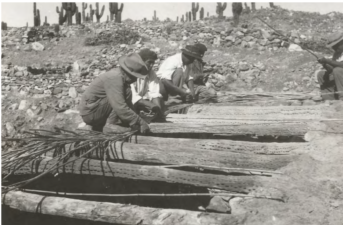
Reconstrucción del Pucará. Se ven Nodocentes techando un recinto del “barrio de la entrada” con cañas sobre bigas de cardón. Pucará de Tilcara, año estimado 1948
