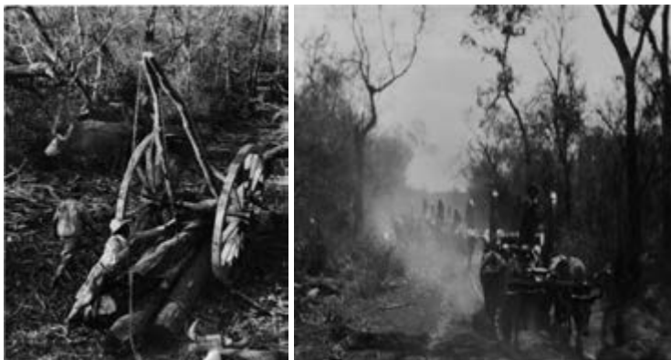
Izquierda: carga de los rollizos al carro cachapé. Derecha: transporte de rollizos a las playas de estacionamiento de madera. Archivo General de la Nación.
