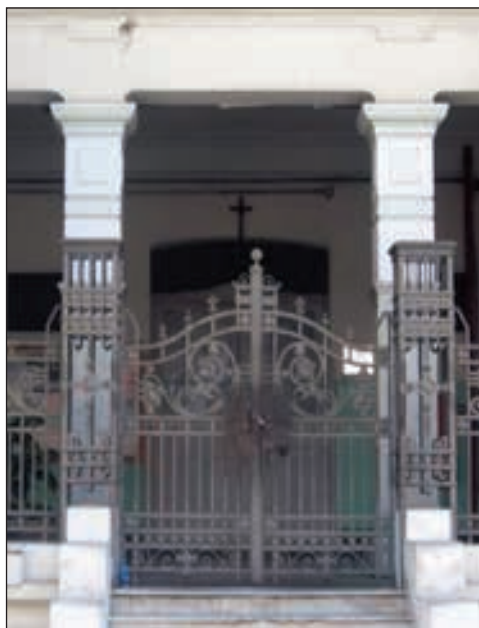
Imagem 2. Detalhes dos originais gradis de ferro e porta de madeira e vidro, vasados, na entrada de uma escola campeira dos anos de 1920. Fotografia do acervo da autora.
