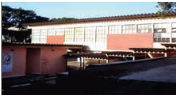
Imagem 3. Vista lateral do mini teatro de arena (com palco e camarim) e do bloco de sala de aulas construído sob pilotis, em escola pública em Campinas (década de 1960). Fotografia do acervo de Rayane J. A. da Silva.
