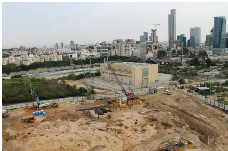
Figura 10.2. Aspecto general del sitio durante la excavación, vista al noreste (fotografía: Yitzhak Marmelstein).
