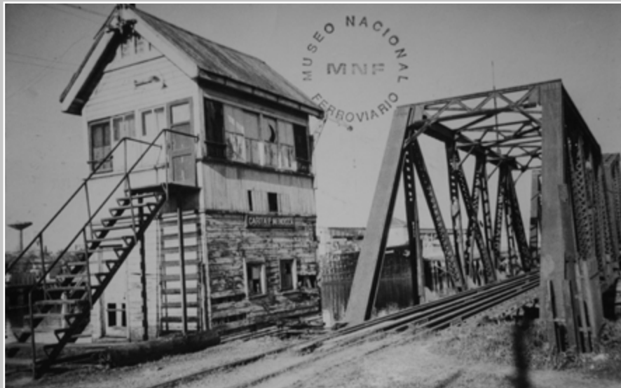
Puente ferroviario Barraca Peña (Museo Nacional Ferroviario).
