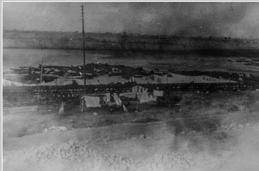
Viaducto calle Garay (Museo Nacional Ferroviario).
