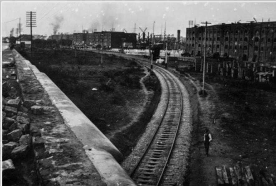
Entrada a túnel Puerto Madero (Museo Nacional Ferroviario).
