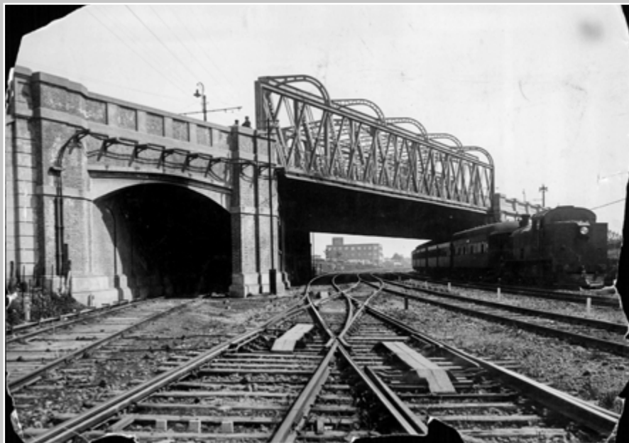
«Puente sobre cruce del F.C. 22 JUN 1935. Puente Av. San Martín sobre F.C.B.A.P.» (AGN, caja 482, sobre 1, inventario 20.189).
