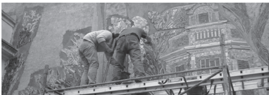
Casona "Marco del Pont" (CABA).
