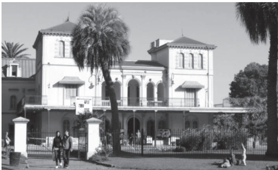
Casona de los Olivera (estado actual).
